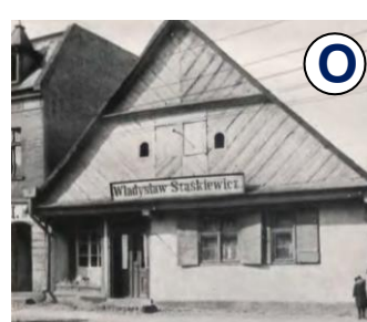
Dom mieszkalny z XIX w.
