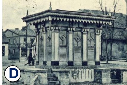
Studnia św. Bernarda z obudową z XIX w.
