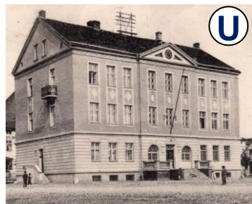
Budynek Urzędu Miejskiego z początku XIX w.
