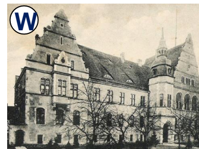
Neobarokowy budynek Sądu Rejonowego.
